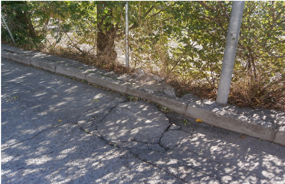
FOTO N° 10. Levantamiento de firme. (MI-Fase 1).
