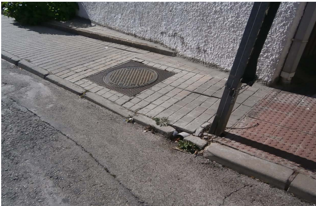
FOTO Nº 2. Bajante bajo acera. (MD-Fase 3).
