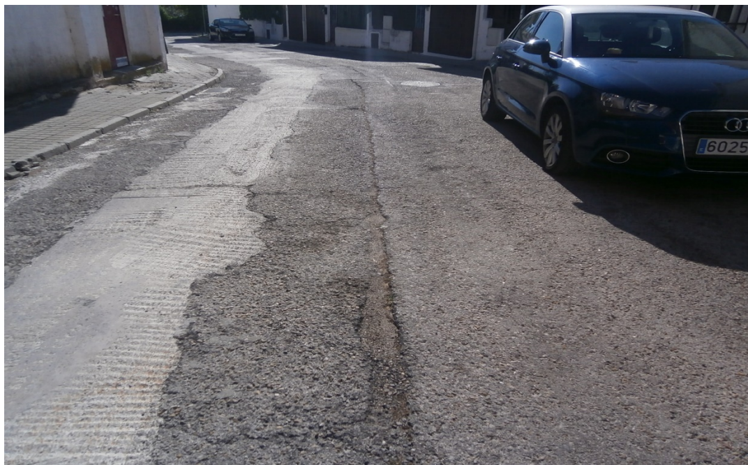
FOTO N° 3. Bache, y parcheado longitudinal y transversal de hormigón (renovación de la red de abastecimiento a lo largo de toda la calzada en margen izquierda).
