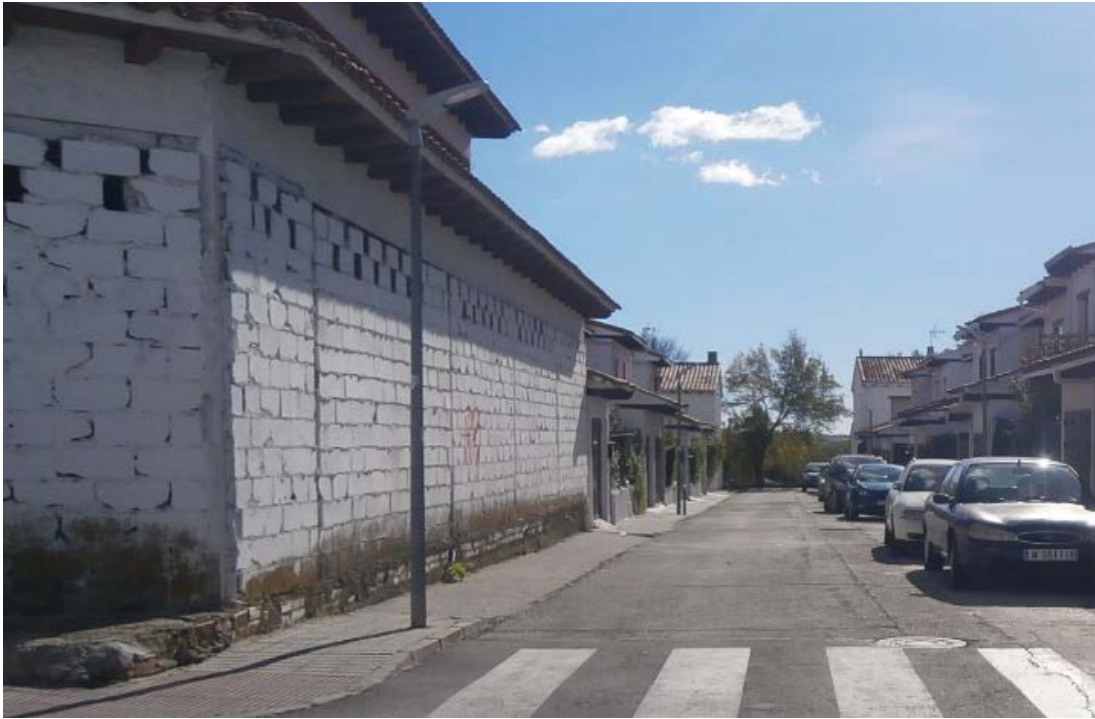
FOTO Nº 1. Tramo sin acera. (MI-Fase 2).
