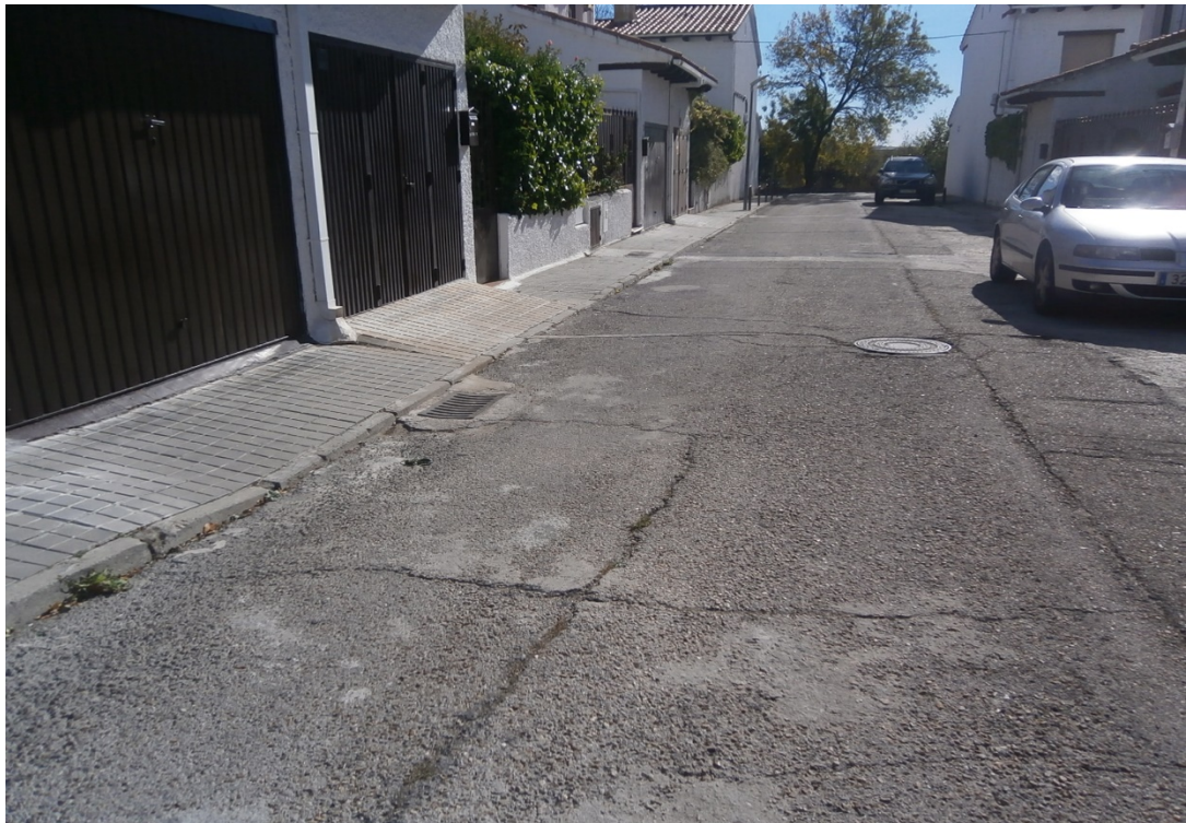
FOTO Nº 6. Acera en buen estado. Viviendas a distintas cotas con respecto a la calle. (MI-Fase 2).
