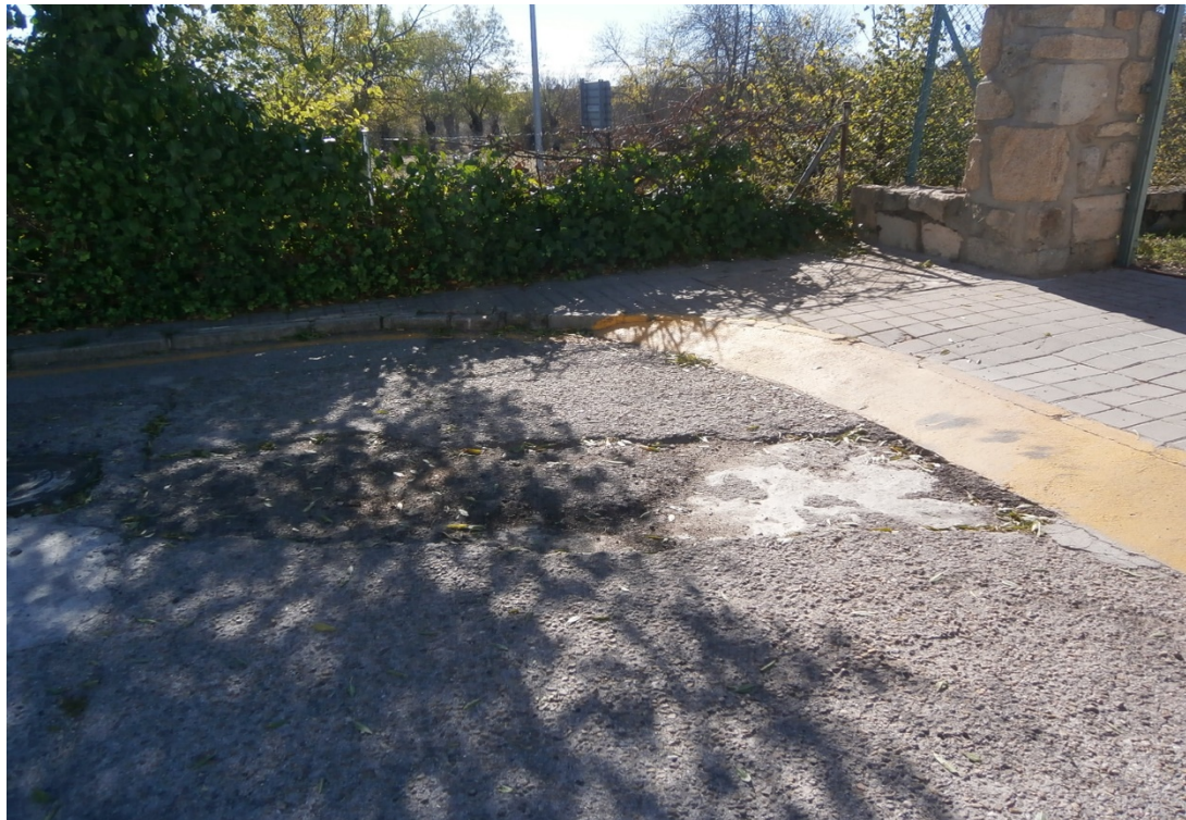
FOTO N° 12. Bache en firme.
