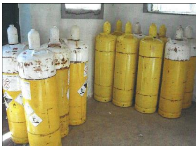
FOTOGRAFÍA 9. ALMACENAMIENTO DE CLORO GAS.
