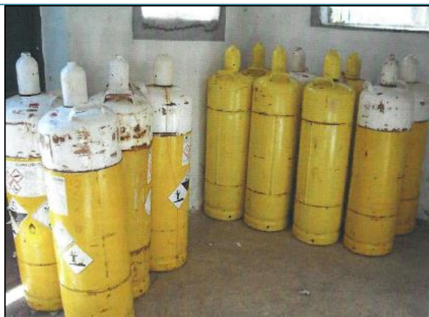
FOTOGRAFÍA 18. ALMACENAMIENTO DE BOMBONAS DE CLORO GAS NO ACORDE A LA NORMATIVA MIE-APQ-3, REGULADA POR RD 379/2001 POR EL QUE SE APRUEBA EL REGLAMENTO DE ALMACENAMIENTO DE PRODUCTOS QUÍMICOS Y SUS INSTALACIONES TÉCNICAS COMPLEMENTARIAS
