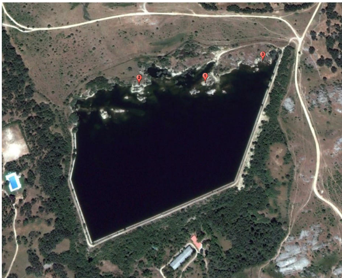
Fotografía 62. Ortofoto con la situación de los pilares de observación en ladera abierta de la balsa
