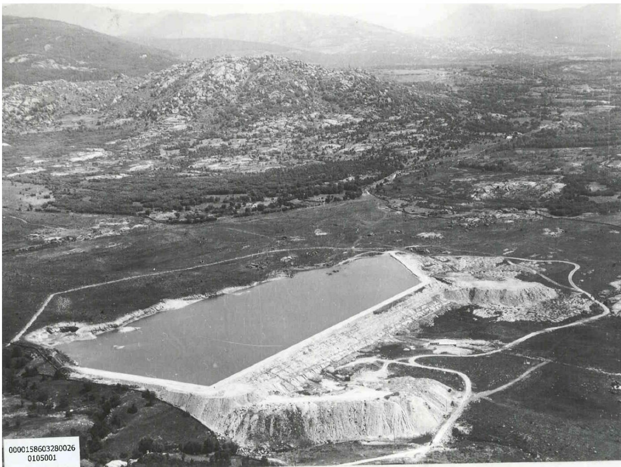
Fotografía 7. Vista aérea de la balsa después de la obra de recrecimiento
