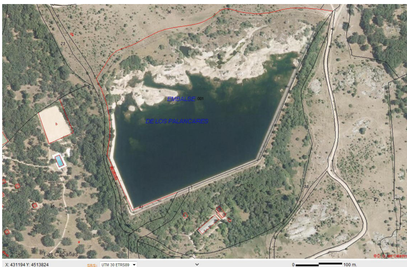
Fotografía 17. Ortofoto actual de la balsa donde se aprecia con mejor detalle la masa arbórea de los taludes exteriores de los diques
