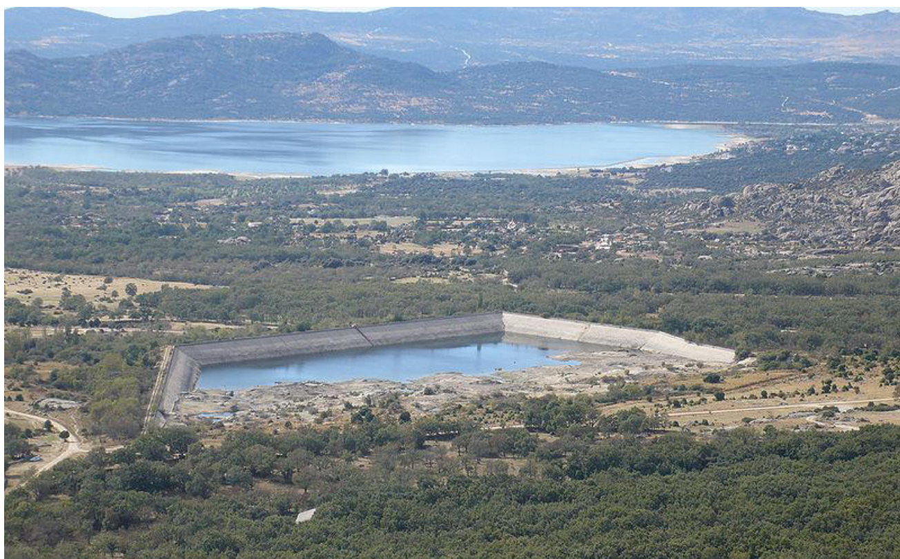
Fotografía 16. Vista aérea con la situación actual de la balsa en la que se observa la gran cantidad de masa arbórea en los taludes exteriores
