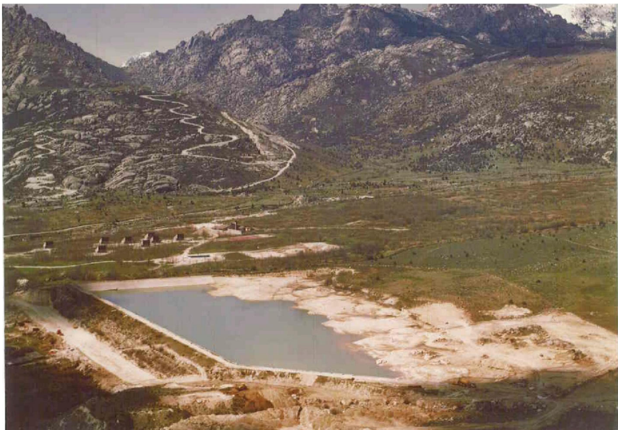
Fotografía 8. Vista aérea de la balsa a medio embalse con la explanación del edificio de la ETAP
