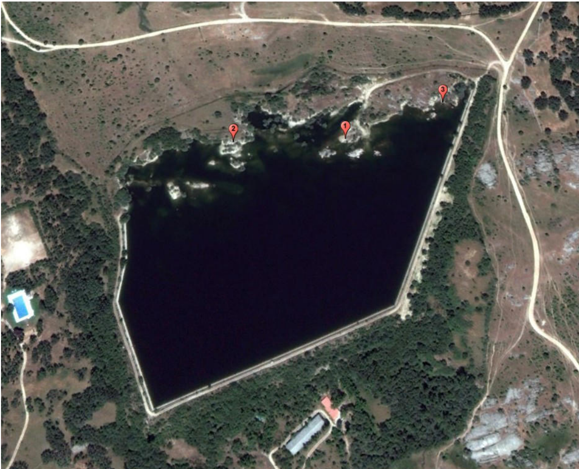
Fotografía 30. Ortofoto con la situación de los pilares de observación en ladera abierta de la balsa
